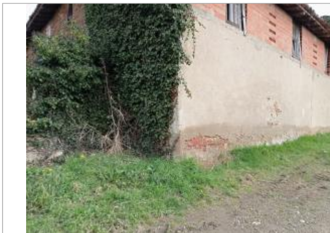
Marque sur structure Photo © AGERIN
