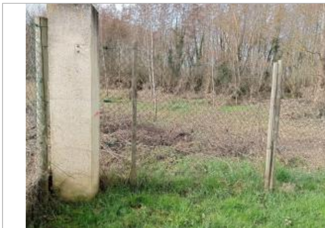
Marque sur structure Photo © AGERIN
