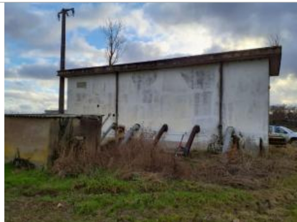
Marque sur structure Photo © AGERIN
