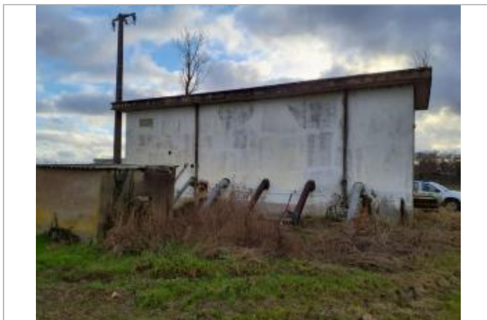
Marque sur structure Photo © AGERIN
