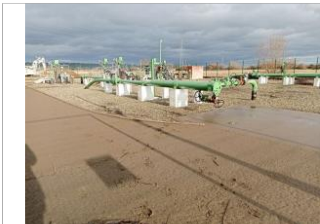
Marque sur structure Photo © AGERIN
