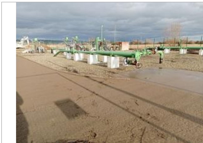
Marque sur structure Photo © AGERIN
