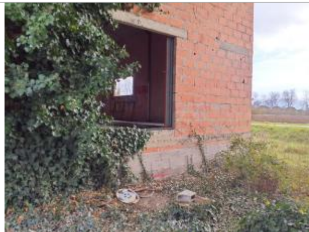
Marque sur structure Photo © AGERIN
