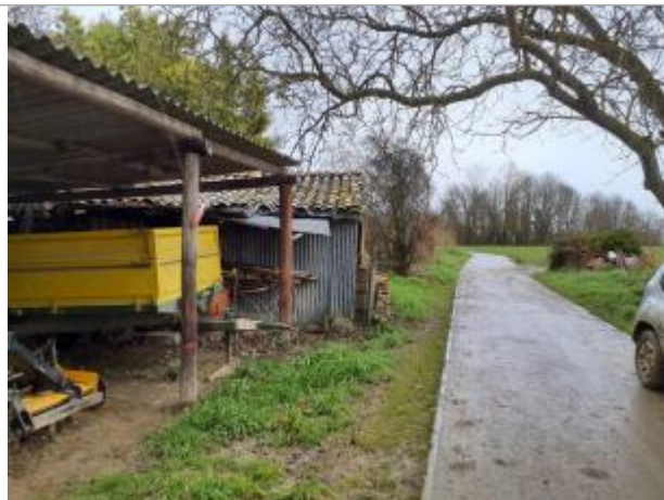
Marque sur structure Photo © AGERIN
