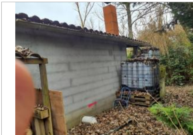
Marque sur Structure Photo © AGERIN
