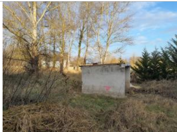
Marque sur structure Photo © AGERIN
