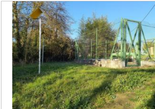
Marque sur structure Photo © AGERIN
