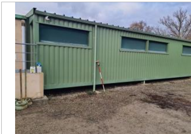
Marque sur structure Photo © AGERIN
