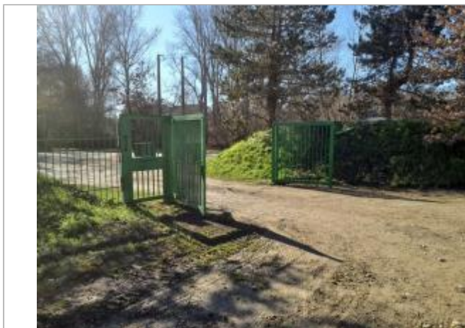
Marque sur structure Photo © AGERIN
