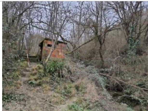
Marque sur structure Photo © AGERIN
