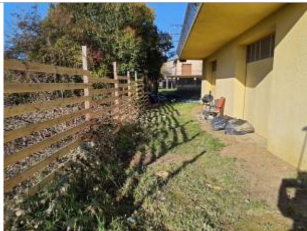
Marque sur structure Photo © AGERIN
