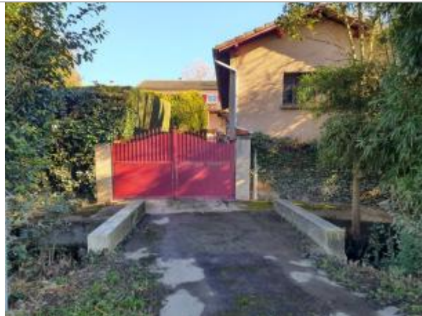
Marque sur structure Photo © AGERIN
