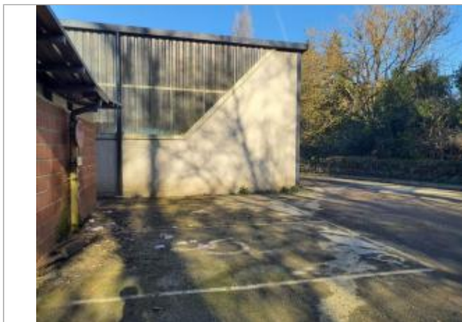
Marque sur structure Photo © AGERIN
