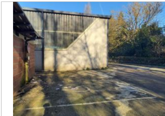
Marque sur structure Photo © AGERIN
