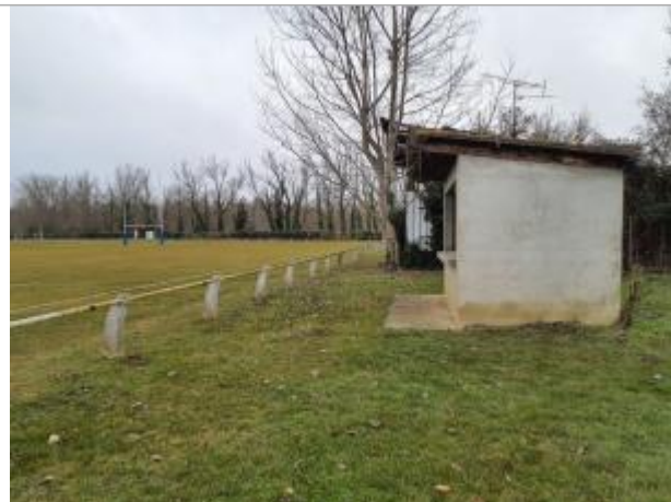
Marque sur structure Photo © AGERIN
