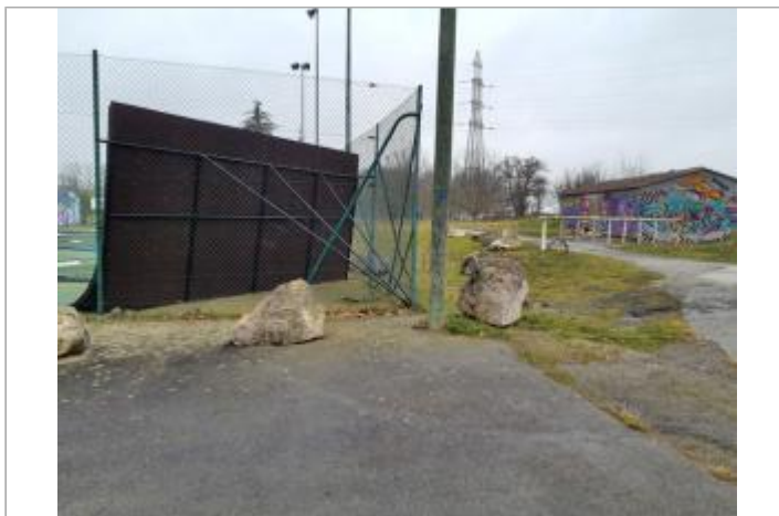
Marque sur structure Photo © AGERIN
