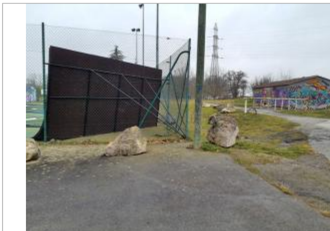
Marque sur structure Photo © AGERIN
