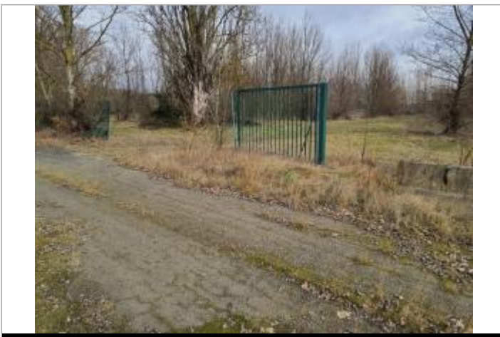
Marque sur structure Photo © AGERIN
