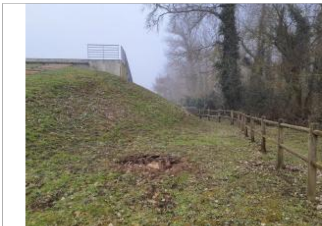
Marque sur structure Photo © AGERIN
