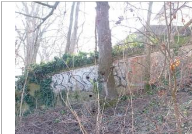
Marque sur structure Photo © AGERIN
