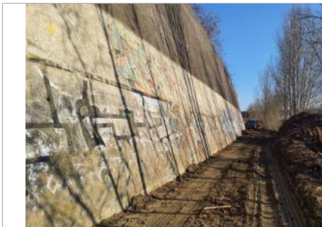
Marque sur structure Photo © AGERIN
