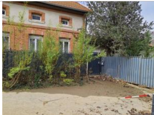
Marque sur structure Photo © AGERIN
