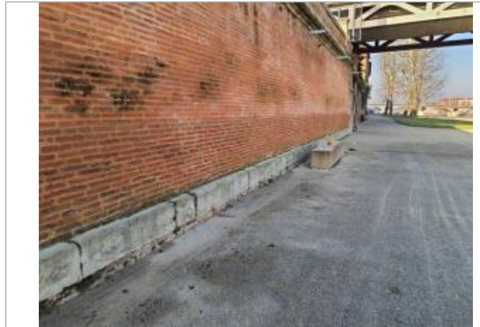
Marque sur structure Photo © AGERIN
