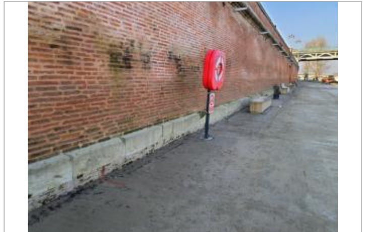
Marque sur structure Photo © AGERIN
