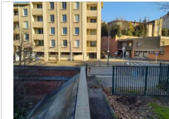
Marque sur structure Photo © AGERIN
