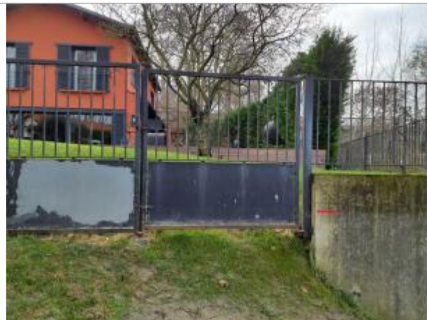
Marque sur structure Photo © AGERIN
