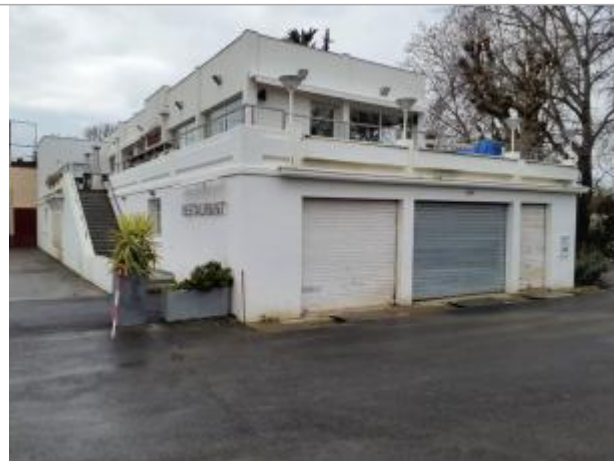
Marque sur structure Photo © AGERIN
