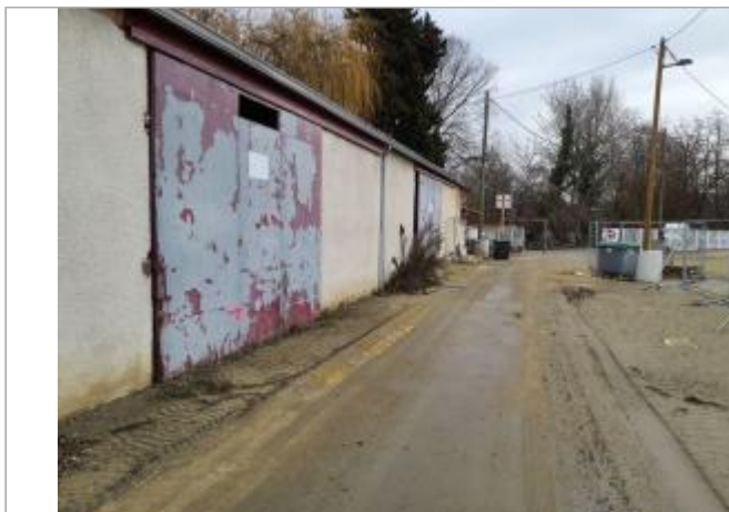
Marque sur structure Photo © AGERIN
