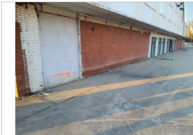
Marque sur structure Photo © AGERIN
