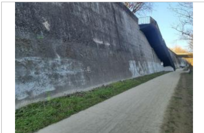
Marque sur structure Photo © AGERIN
