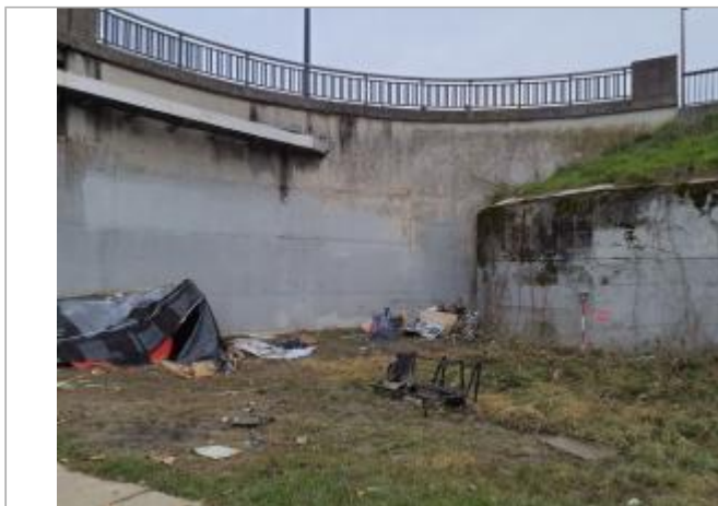
Marque sur structure Photo © AGERIN
