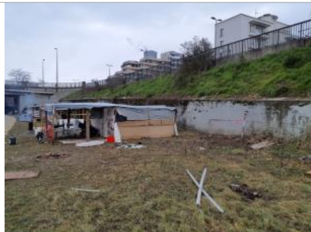
Marque sur structure Photo © AGERIN
