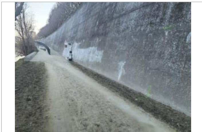
Marque sur structure Photo © AGERIN
