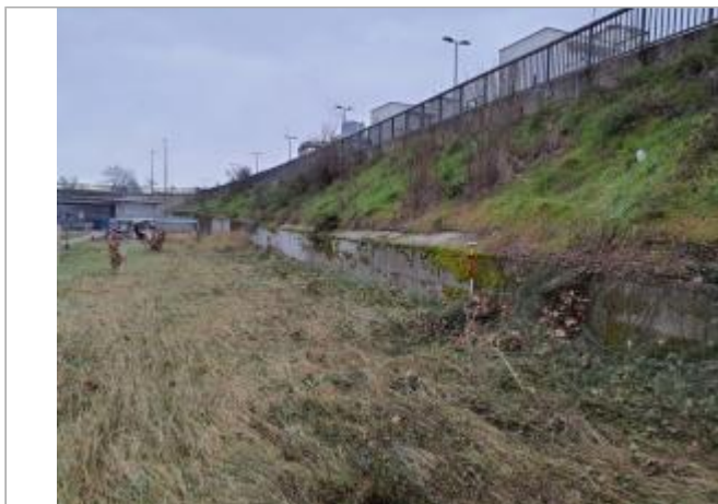
Marque sur structure Photo © AGERIN
