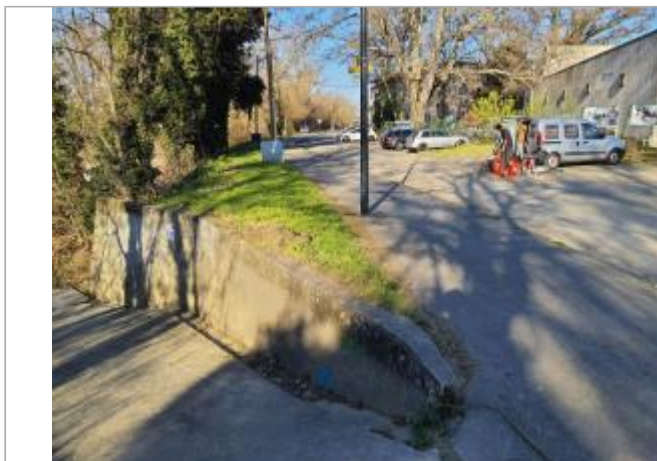
Marque sur structure Photo © AGERIN
