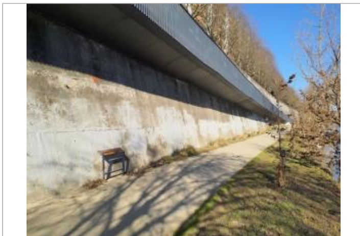
Marque sur structure Photo © AGERIN
