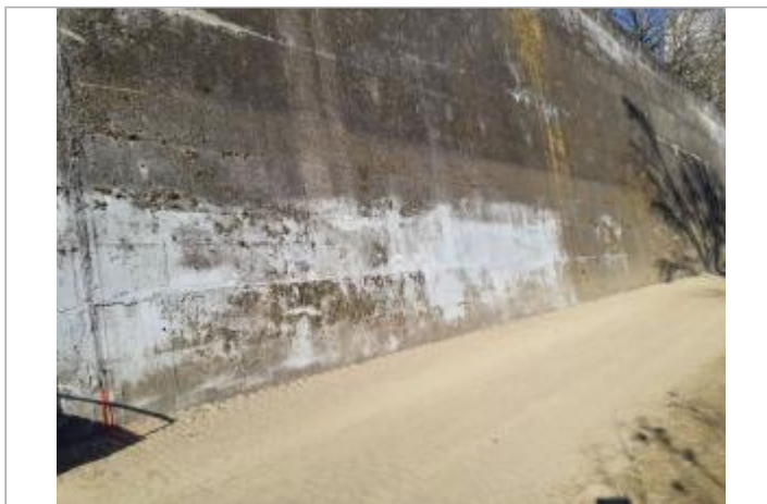
Marque sur structure Photo © AGERIN
