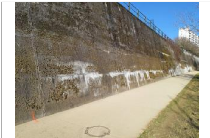
Marque sur structure Photo © AGERIN
