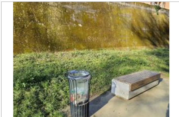
Marque sur structure Photo © AGERIN
