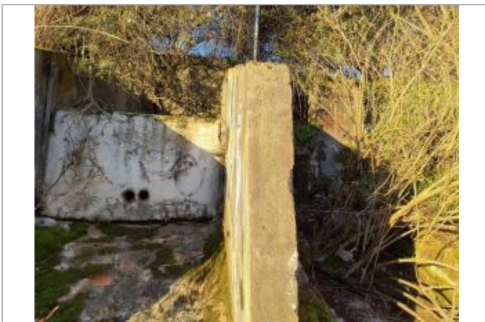
Marque sur structure Photo © AGERIN
