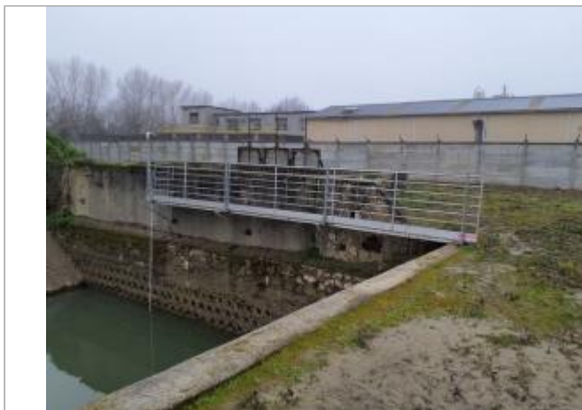
Marque sur structure Photo © AGERIN
