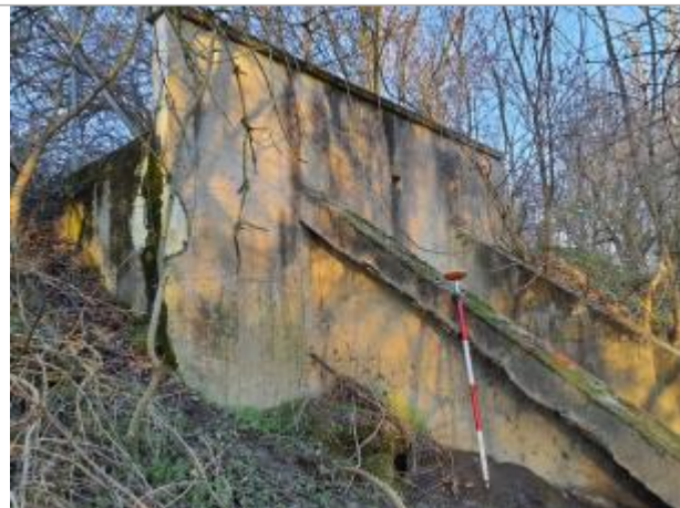
Marque sur structure Photo © AGERIN
