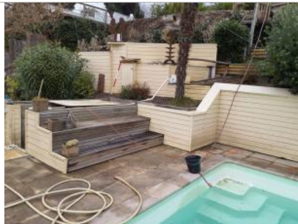
Marque sur structure Photo © AGERIN
