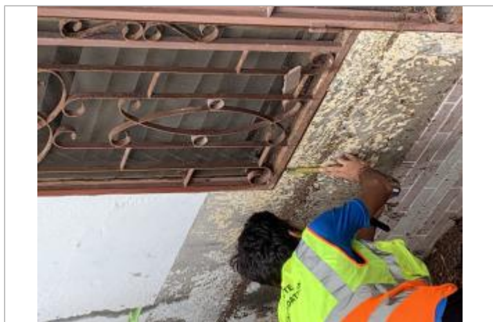
dépôts de matières solides
