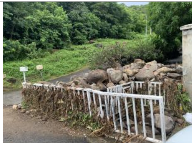
Charriage important sur l'ouvrage
