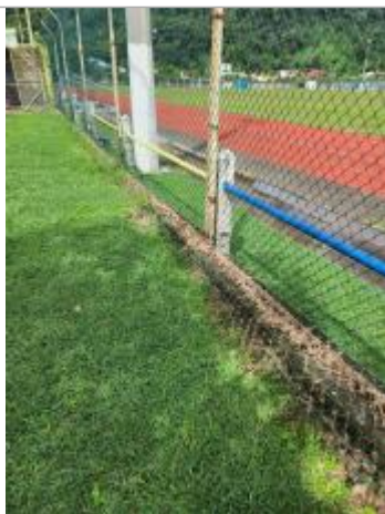
Dépôt de matière solide sur le grillage
