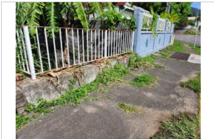
Dépôts matières solides et pont en charge
