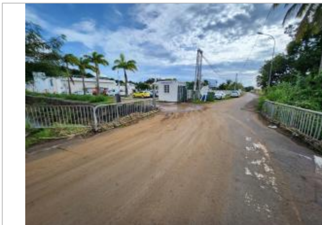
Pont en charge
