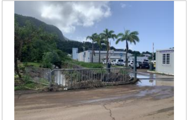
Pont en charge
