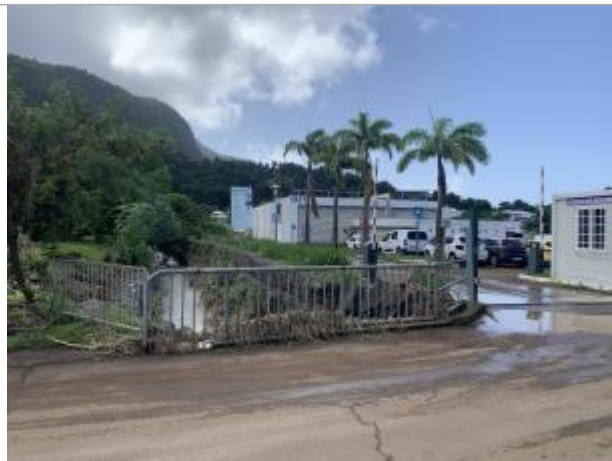
Pont en charge
