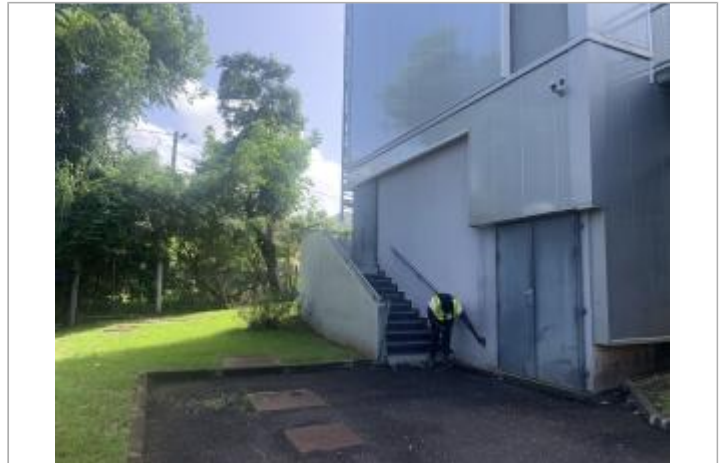
Arrière du bâtiment, à proximité de la ravine Blanche
