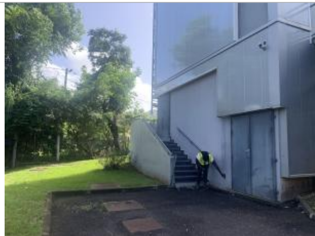
Arrière du bâtiment, à proximité de la ravine Blanche
